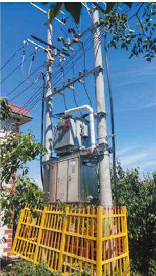
湖南项目现场
