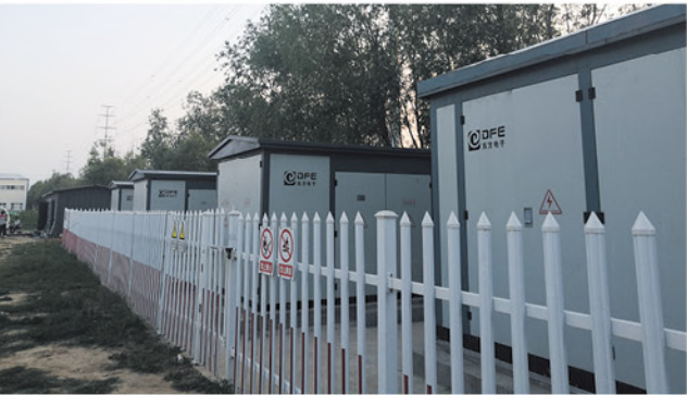
国家电投德州齐河项目现场
