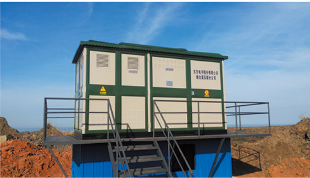
山东蓬莱项目现场
