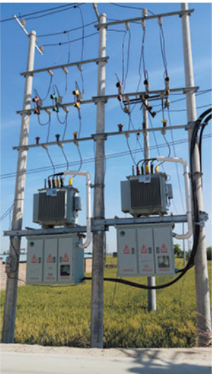
河北项目现场
