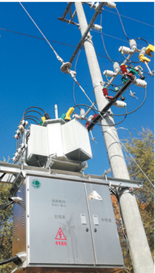
甘肃项目现场
